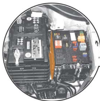
Дополнительная плата реле под блоком предохранителей и реле
